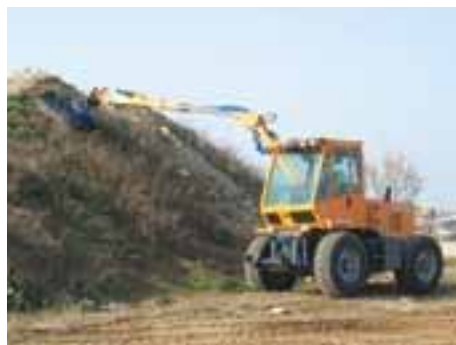
La flèche télescopique latérale permet d'accéder aux talus les plus escarpés.
